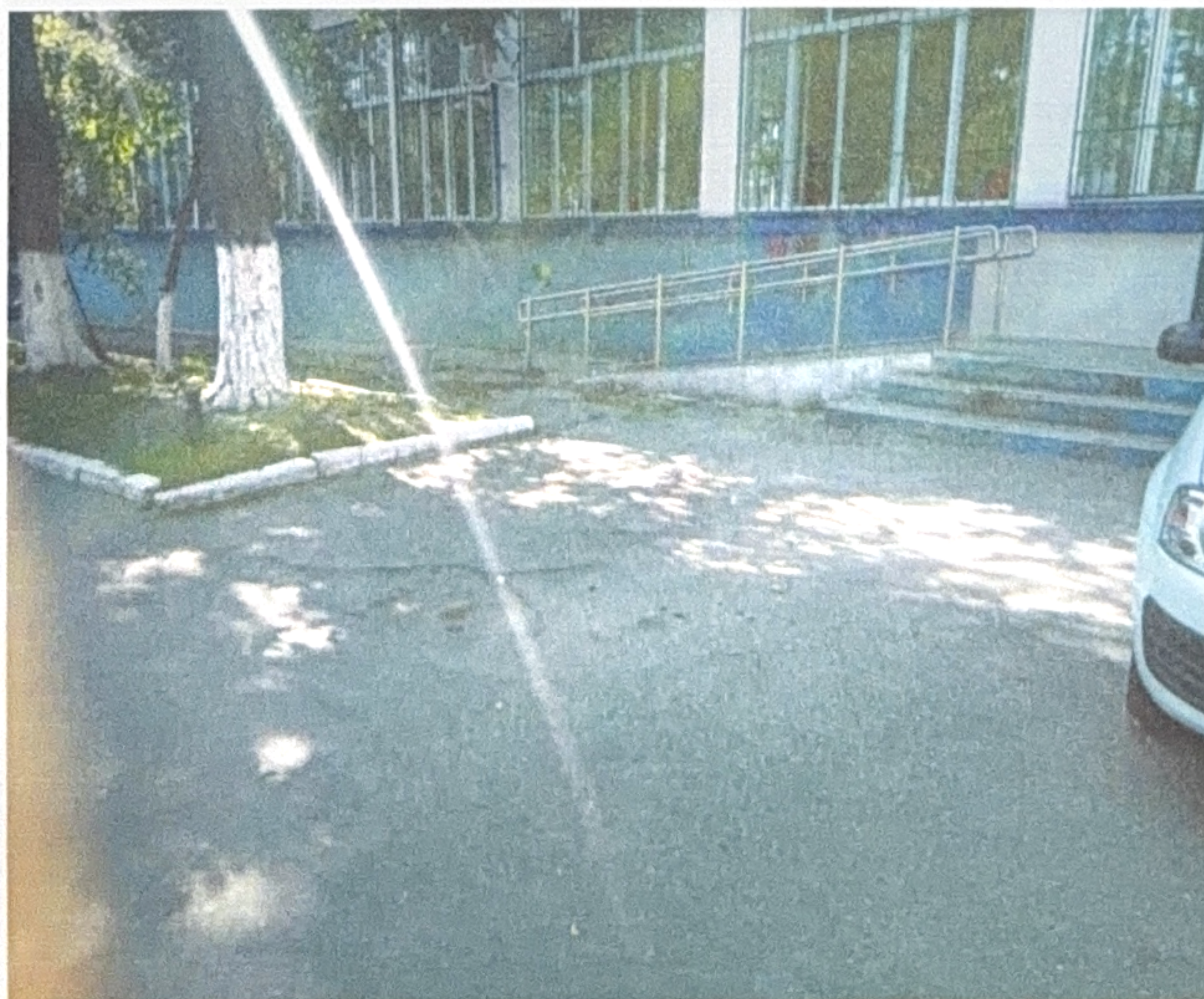
Рис.8. Подходы к объекту Главный вход. Пандус.
