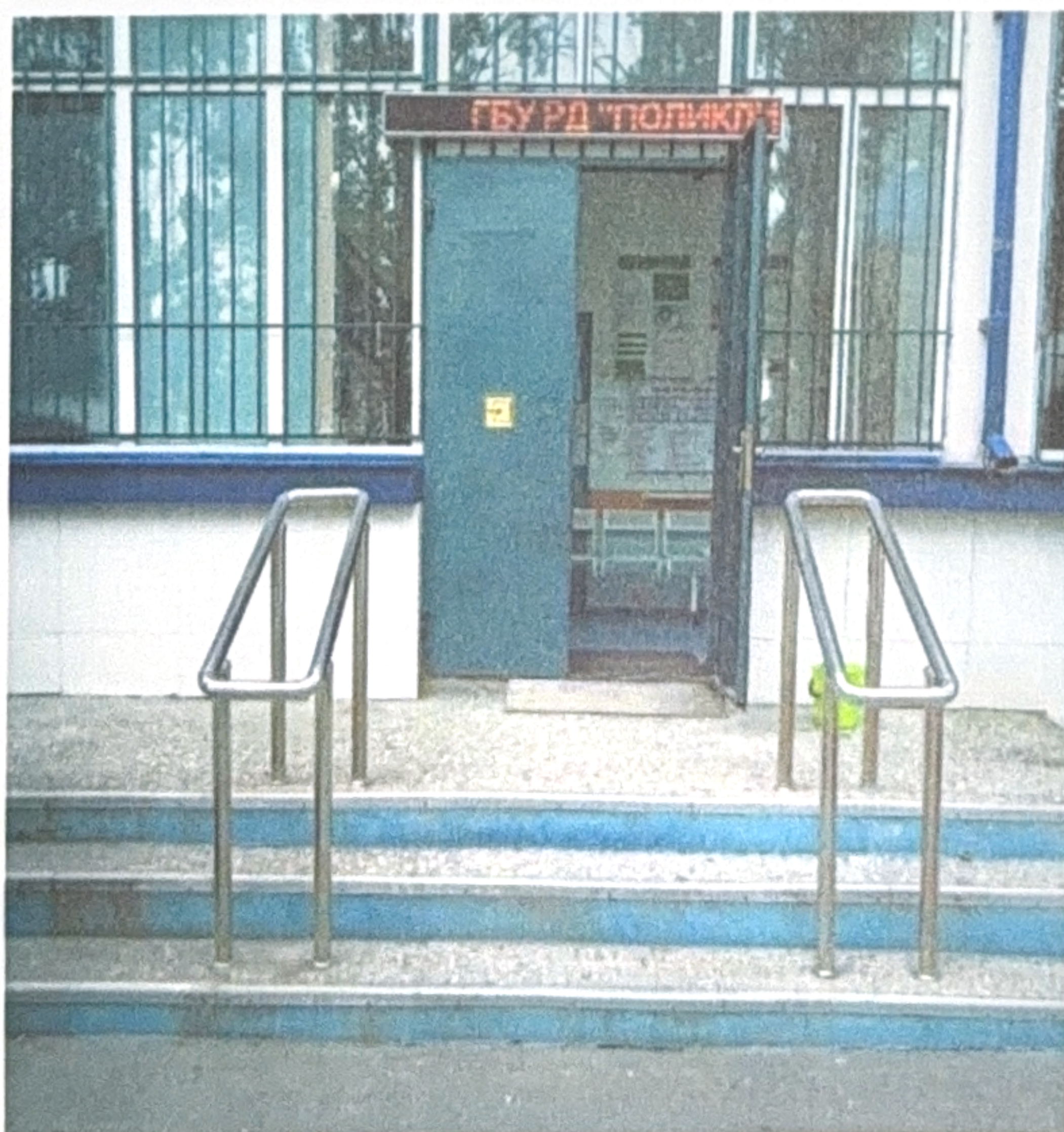
Рис.6. Подходы к объекту Главный вход. Наружная лестница.
