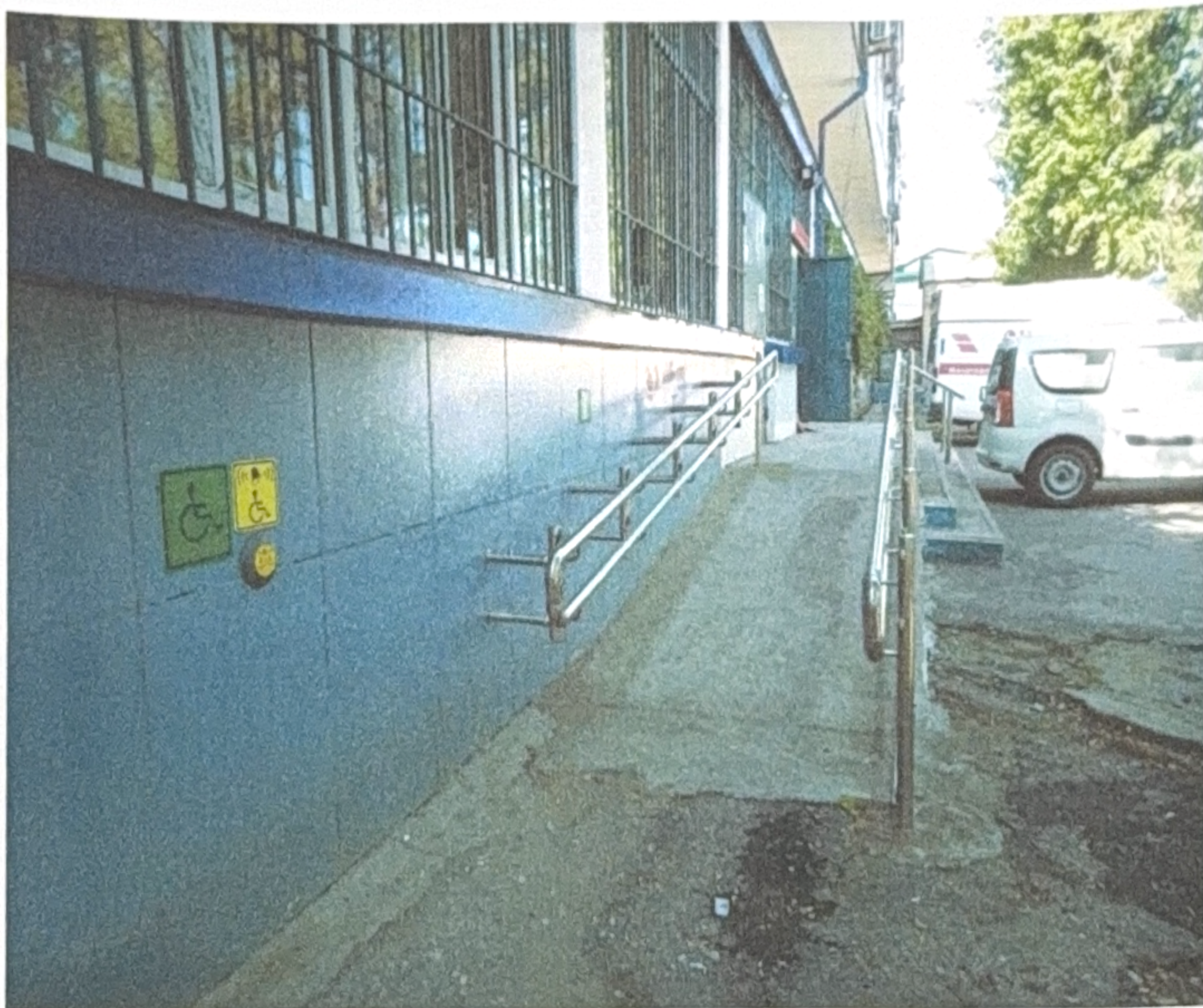
Рис.9. Подходы к объекту Главный вход. Пандус.
